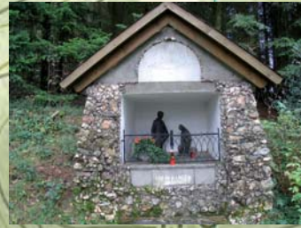
Die Geburtsgrotte – 1924 erbaut mit von Kindern gesammelten Steinen aus den ehemaligen Bönkhäuser Bleigruben
