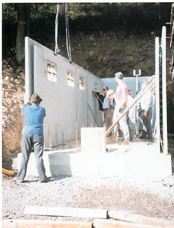
Die Außenwände stehen schon fast.
