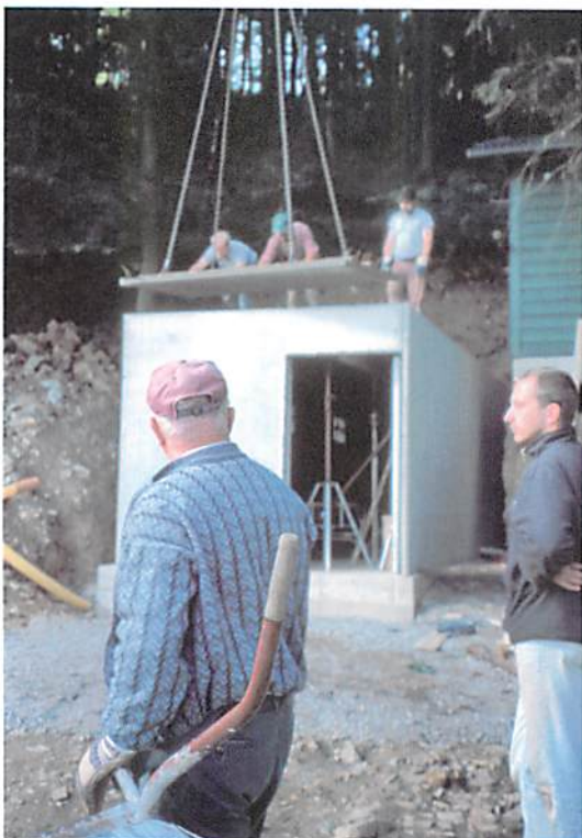
Ruck-Zuck wird noch eben die Decke verlegt...
