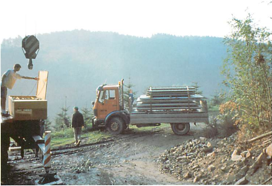
Anlieferung der Betonsandwichelemente, aus denen die Kellerwände erstellt werden.
