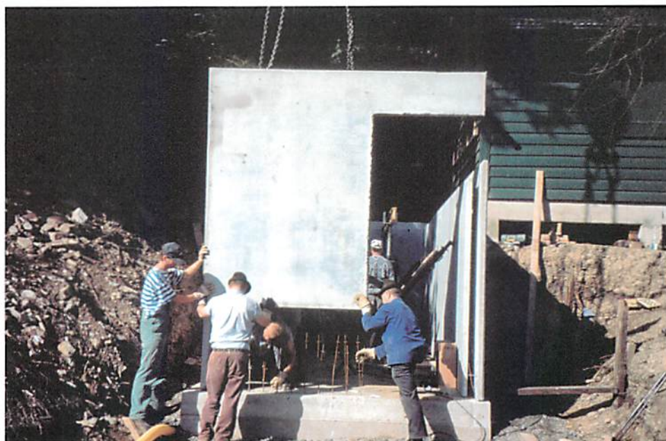
Und schon wird das letzte Wandelement aufgestellt.
