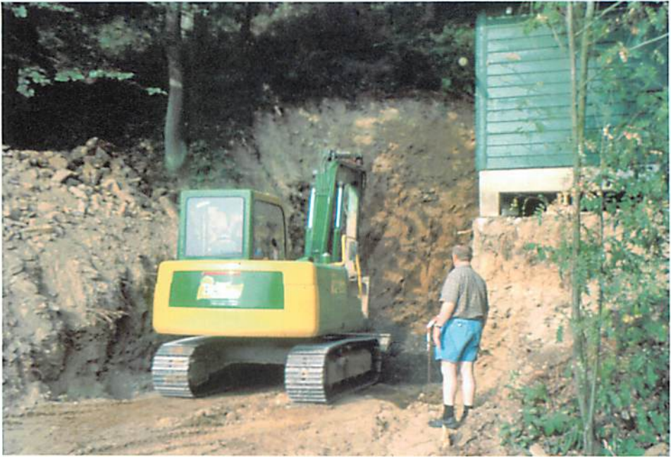
Schachtet der denn auch richtig? Unter der Aufsicht von „Bauleiter“ Clemens Grothe gehen die Arbeiten zügig voran.
