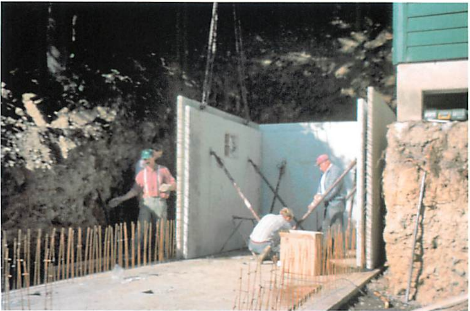
Der grobe Umriss des Anbaues ist zu erkennen, nachdem die ersten Elemente aufgestellt sind.
