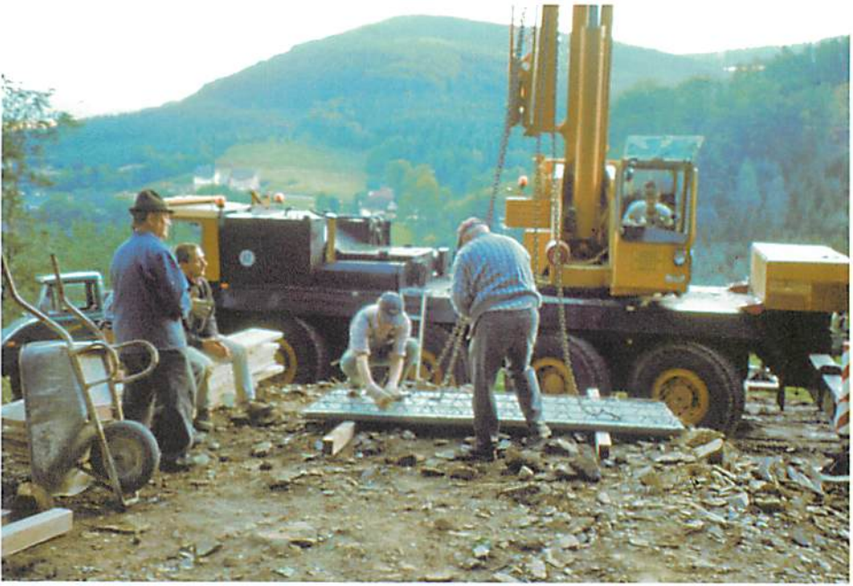
Auch kleine Elemente werden per Kran verlegt.
