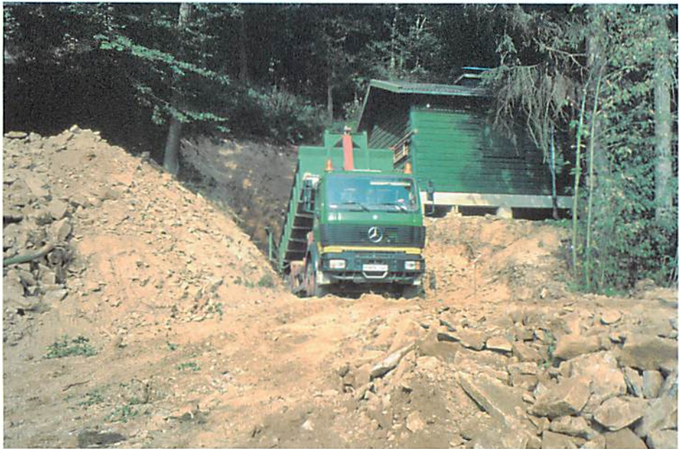
Der erste Schotter wird angeliefert - es geht wieder aufwärts.
