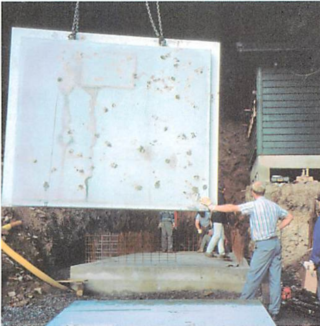
Das erste Wandelement „schwebt“ ein.
