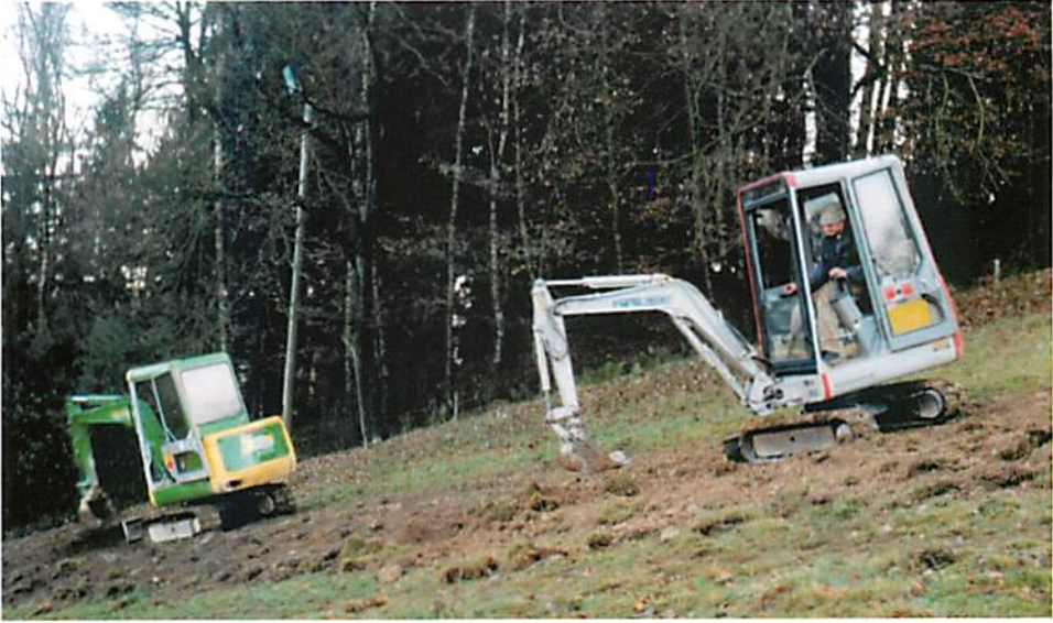
Nachdem die Leitung verlegt war, wurde alles direkt wieder verfüllt und einplaniert.
