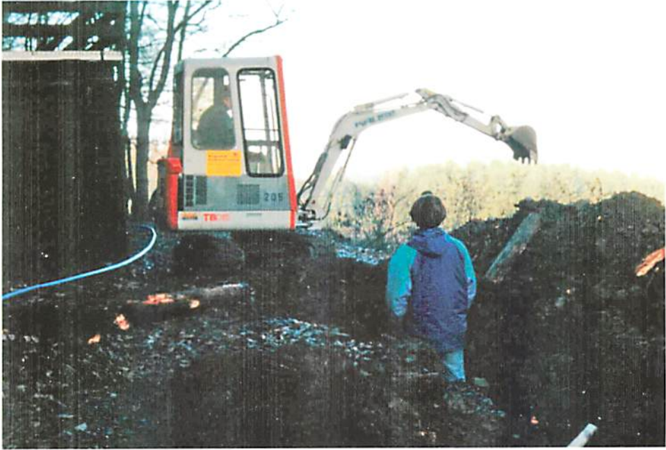
Aushub des Rohrgrabens.
